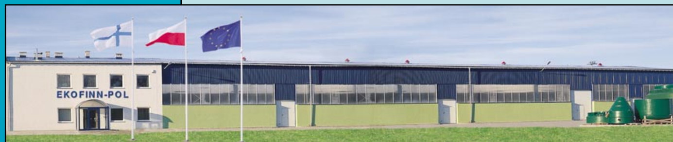
Siedziba i hala montażowa EKOFINN-POL
